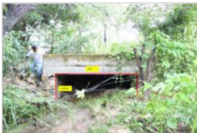
Fotografía 82. Puente de mampostería que transporta el arroyo a la altura del Vivero Jardines de Terán.
