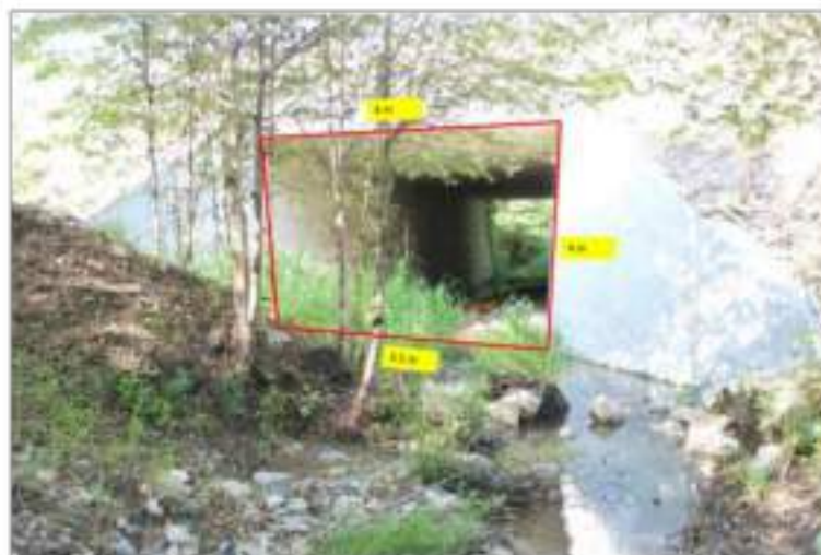
Fotografía 99. Paso del escurrimiento por puente hidráulico debajo del Nuevo Libramiento Sur.
