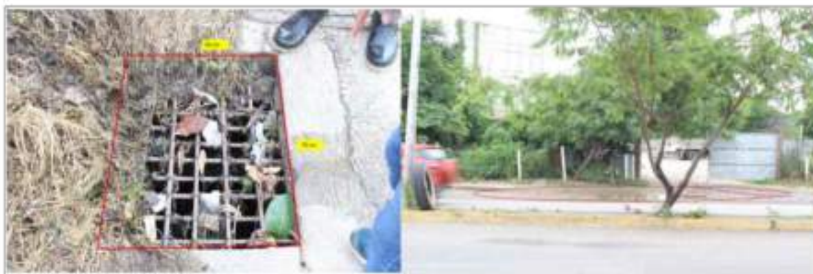
Fotografía 83 (izq.). Alcantarilla pluvial en calzada Emiliano Zapata (481470, 1848776 UTM, Tabla 20).
