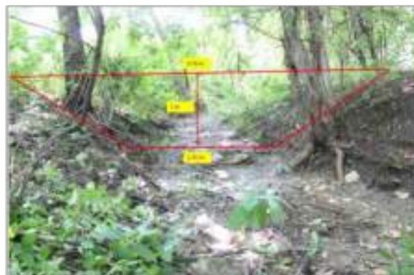
Fotografía 110. Arroyo natural con dimensiones de 1.55 m en la base menor y 1 m de profundidad.
