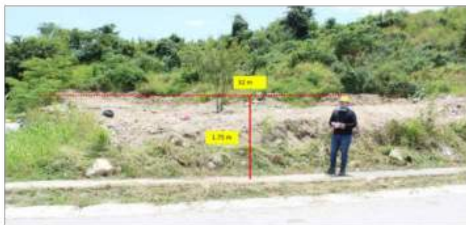
Fotografía 143. Talud con material de relleno en boulevard Real del Bosque (481612, 1846523 UTM).
