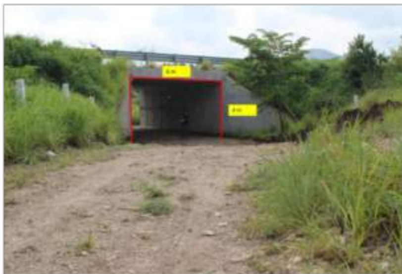
Fotografía 34. Camino de terracería por debajo del puente del Nuevo Libramiento Sur.
