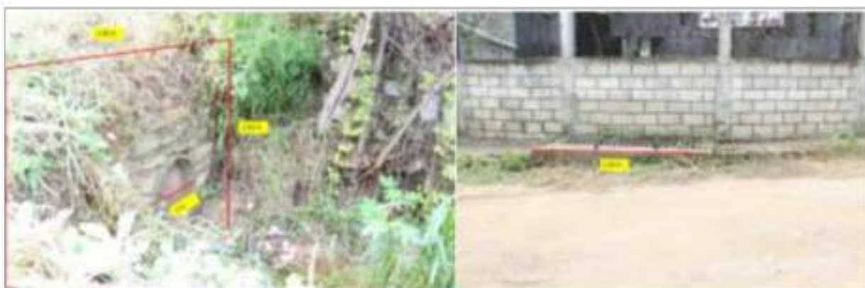
Fotografía 68 (izq.). Paso del escurrimiento natural a través de tubo de concreto. Fotografía 69 (der.). Alcantarilla pluvial que transporta el escurrimiento por la zona urbana.
