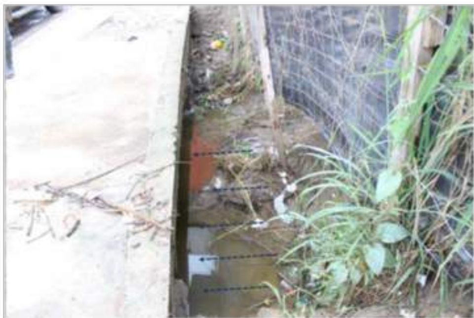
Fotografía 70. Canal para descargas pluviales.
