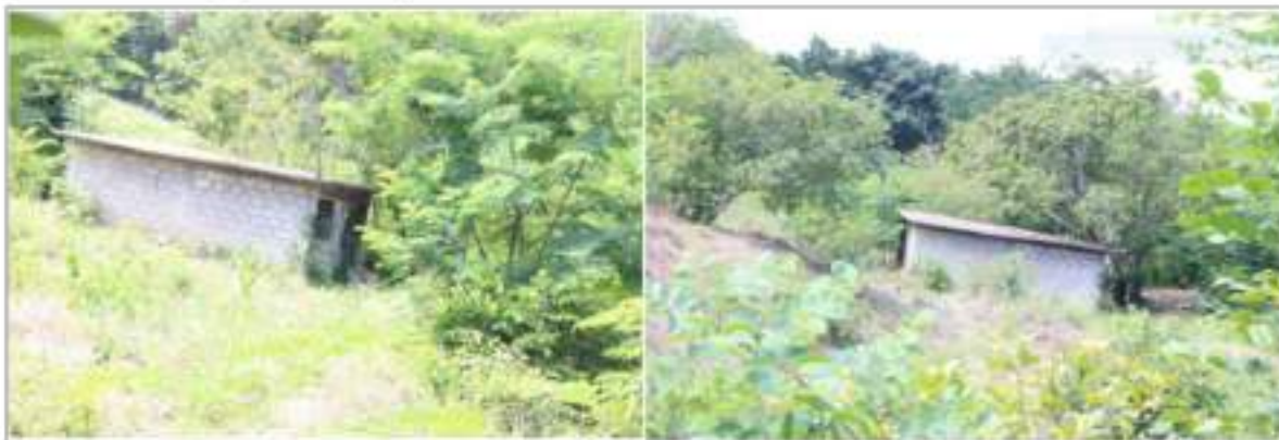
Fotografías 214 y 215. Punto de control 3 (483133, 1849462 UTM,), vivienda construida en pendiente pronunciada.
