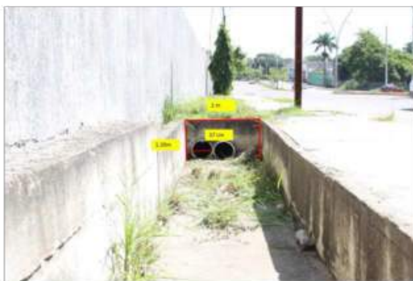
Fotografía 94. Canal pluvial que pasa por el fraccionamiento Bonanza.
