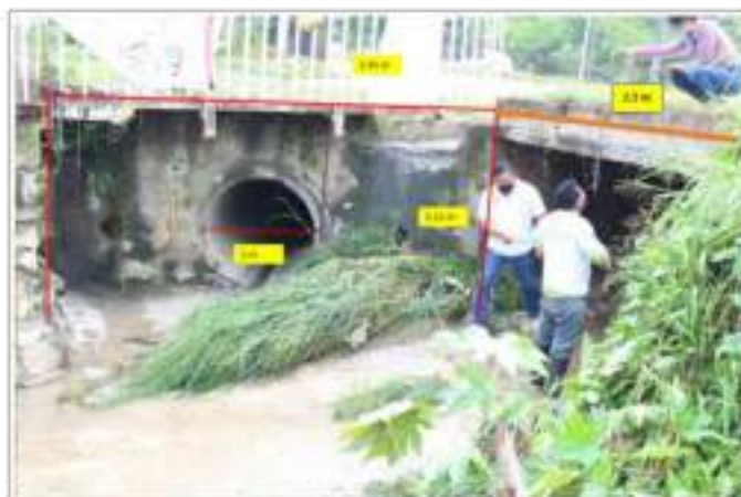
Fotografía 85. Intersección de dos puentes sobre la calzada Emiliano Zapata (481442, 1848676 UTM, Tabla 20).
