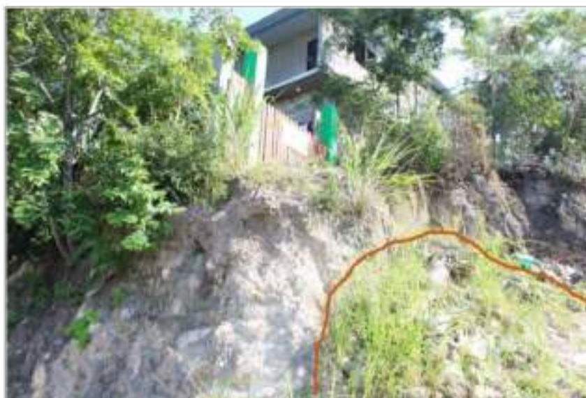
Fotografía 191. Punto de control 5, construcción social del riesgo en colonia Nueva Jerusalén: casa construida sobre talud inestable.
