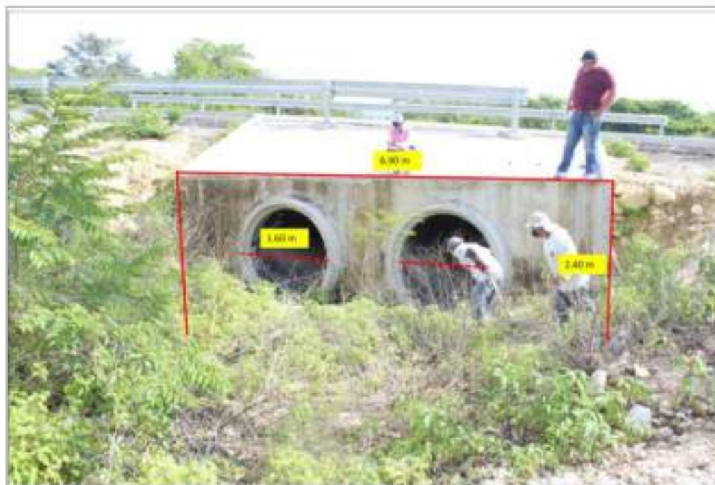
Fotografía 114. Puente alcantarilla (475291, 1849085 UTM).
