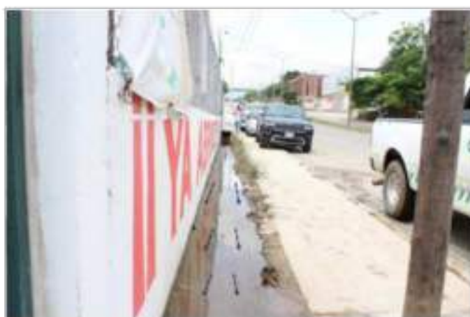
Fotografía 62. Canal pluvial sobre la calzada Emiliano Zapata, que distribuye el escurrimiento natural que fue modificado por la construcción de viviendas.
