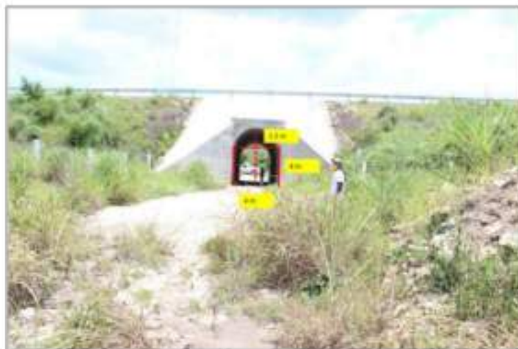
Fotografía 117. Paso de terracería por debajo del Nuevo Libramiento Sur.
