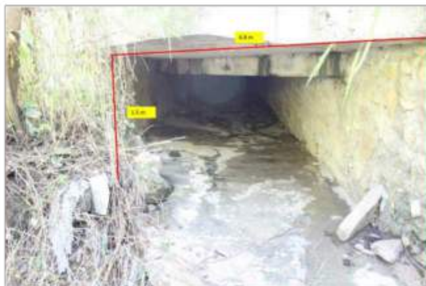
Fotografía 96. Canal pluvial que atraviesa la calzada Emiliano Zapata.
