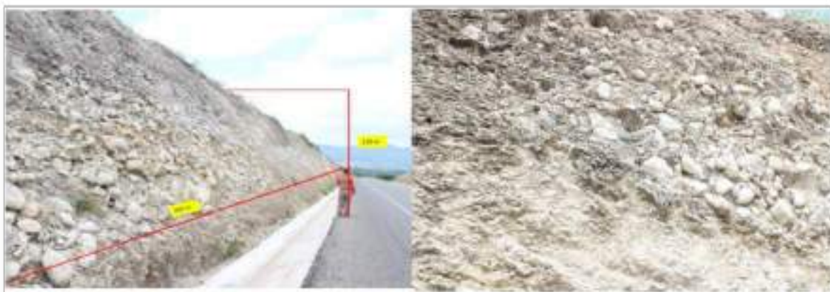
Fotografía 176 (izq.). Se observa talud de 3.65 m de altura. Fotografía 177 (der.). Detalle del tipo de material encontrado en el Nuevo Libramiento Sur.
