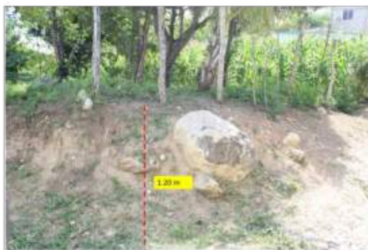
Fotografía 224. Corte de talud de 1.20 m de altura en punto de control 12 (482394, 1848842 UTM).
