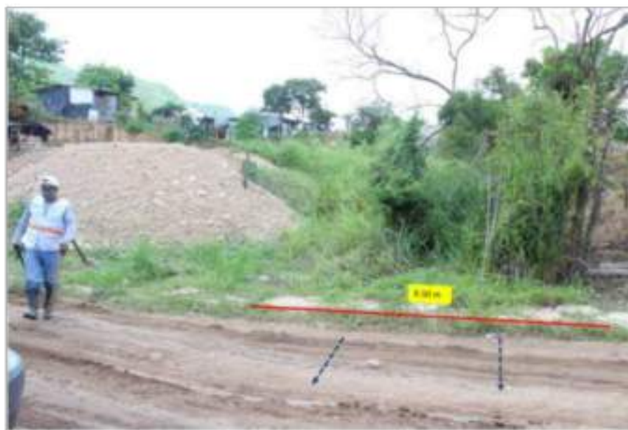
Fotografía 43. Modificación del cauce natural por la vialidad. El agua cruza el camino de terracería.
