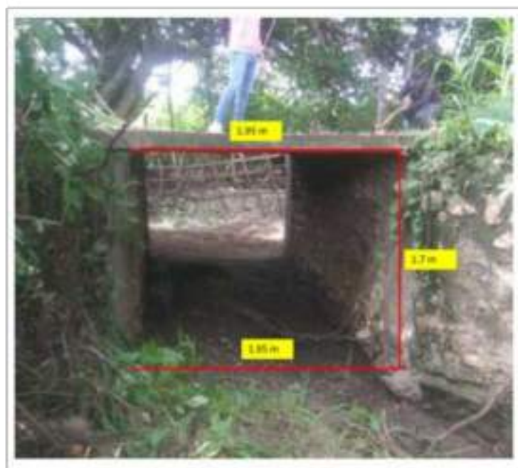
Fotografía 15. Puente vehicular con altura de 1.7 m y 1.95 m de anchura.
