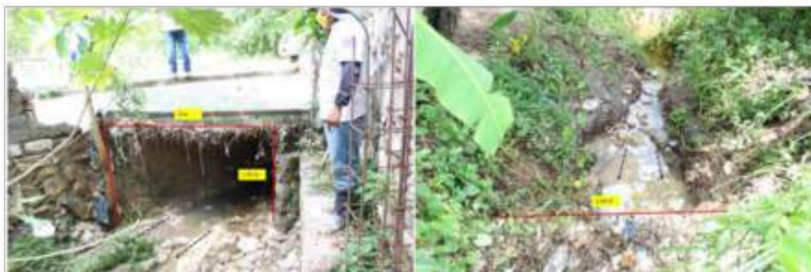
Fotografía 66 (izq.). Puente y canal de mampostería que transporta el escurrimiento por debajo de vialidad en la colonia Loma Bonita, y se dirige a su entorno natural. Fotografía 67 (der.). Canal de 2.50 m.
