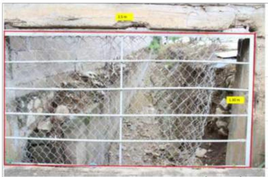
Fotografía 73. Puente peatonal sobre canal pluvial en calzada Emiliano Zapata.
