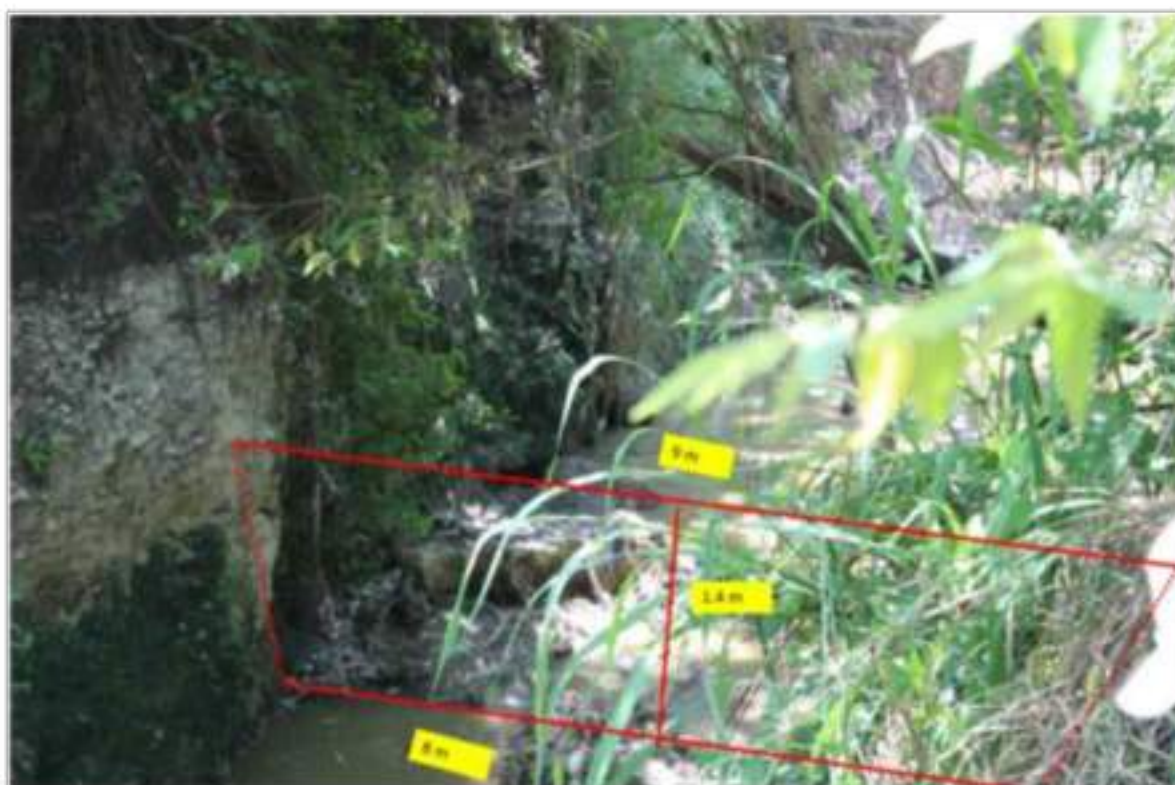
Fotografía 58. En este punto se observa el cauce contaminado con aguas residuales. Sus dimensiones son de 8 m de ancho y 1.4 m de alto.
