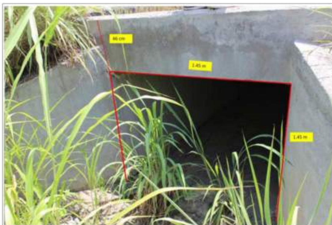
Fotografía 36. Salida del puente en el ala sur del Nuevo Libramiento Sur.
