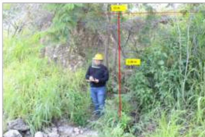
Fotografía 145. Talud de caliche y macizo cementado en camino rural a Pacú.
