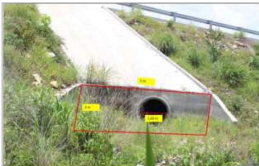
Fotografía 119. Lavadero pluvial 477020, 1848499 UTM.
