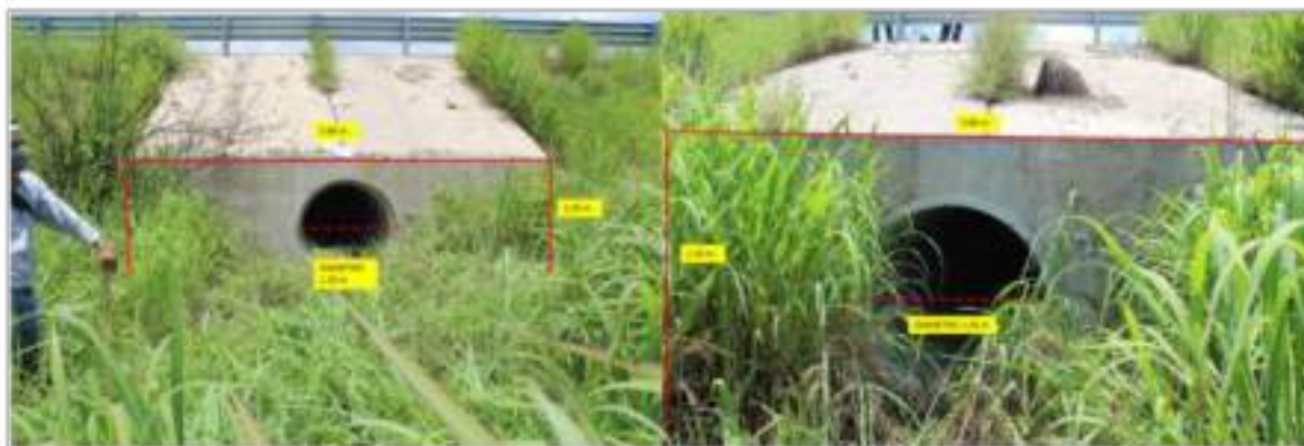
Fotografía 37 (izq.). Ingreso de los escurrimientos pluviales por debajo del Nuevo Libramiento Sur.
