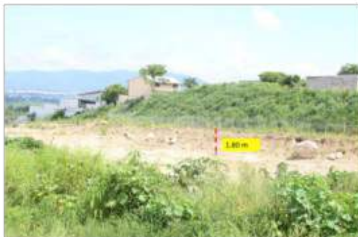
Fotografía 225. Corte de talud de 1.80 m de altura en punto de control 13 (482481, 1849154 UTM).
