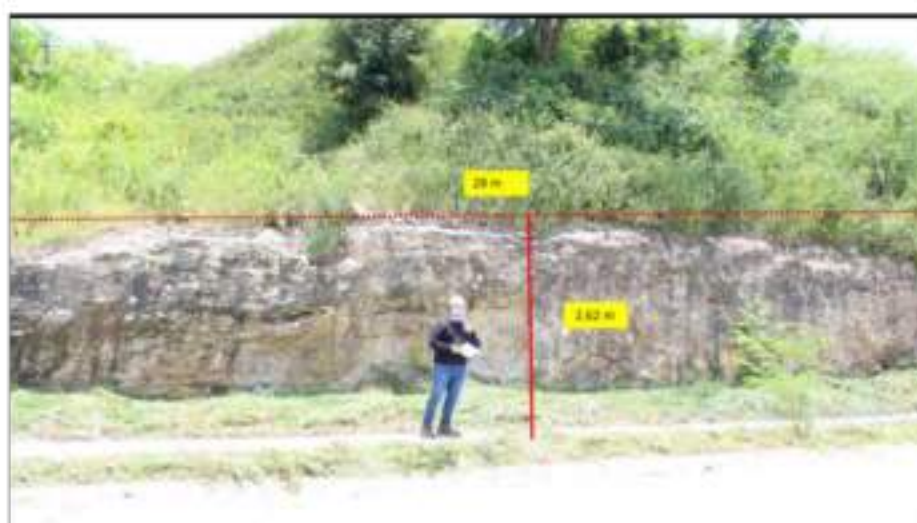
Fotografía 144. Talud de 28 m de longitud y 2.62 m de altura, en boulevard Real del Bosque.
