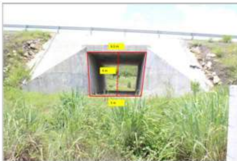
Fotografía 120. Puente en forma de trapecio 477061, 1848458 UTM.
