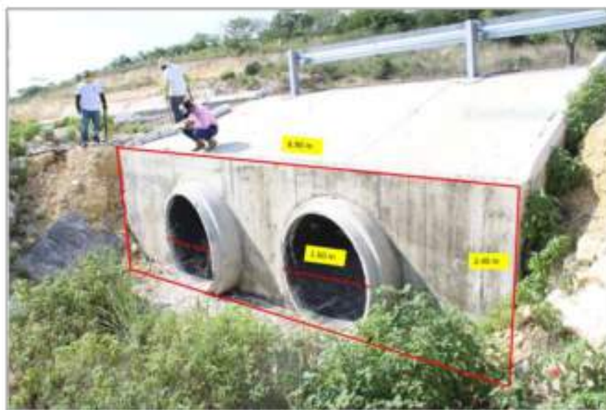
Fotografía 116. Puente alcantarilla 476365, 1848836 UTM.
