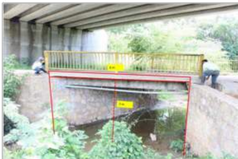
Fotografía 124. Arroyo fluye por debajo de puente sobre el Nuevo Libramiento Sur.
