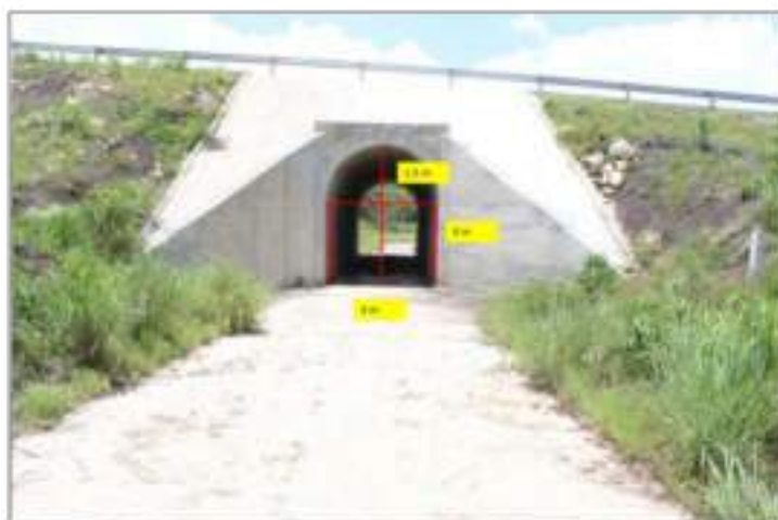
Fotografía 118. Puente sobre el Nuevo Libramiento Sur, altura y anchura de 4 m, arco superior con radio de 1.5 m.
