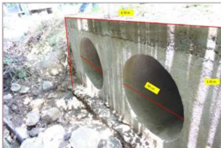
Fotografía 113. Puente vehicular con tubos de concreto (477037, 1848590 UTM).
