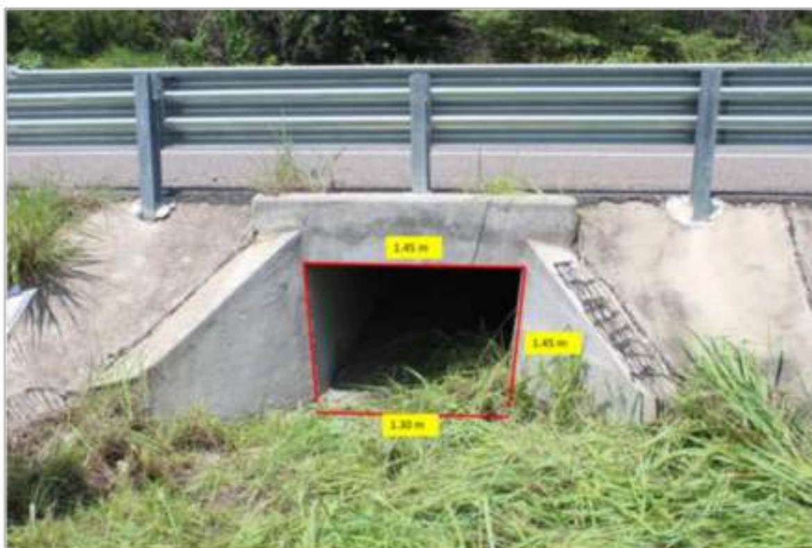
Fotografía 35. Puente del Nuevo Libramiento Sur en zona parcelada sin asentamientos humanos.
