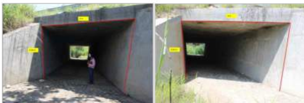
Fotografía 32 (izq.). Entrada del arroyo al Nuevo Libramiento Sur, 481832, 1845050 UTM. Fotografía 33 (der.). Puede observarse la salida del arroyo para continuar su cauce hacia el sur.
