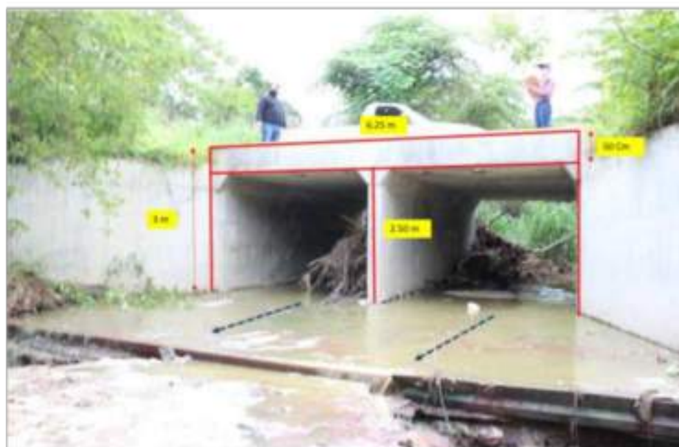
Fotografía 55. Puente con pila intermedia.
