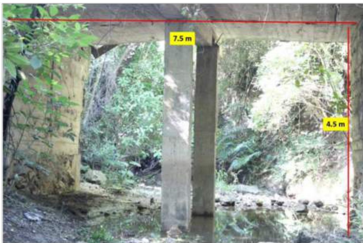
Fotografía 97. Puente de cemento con columnas que permite el paso del arroyo con dirección al Nuevo Libramiento Sur.
