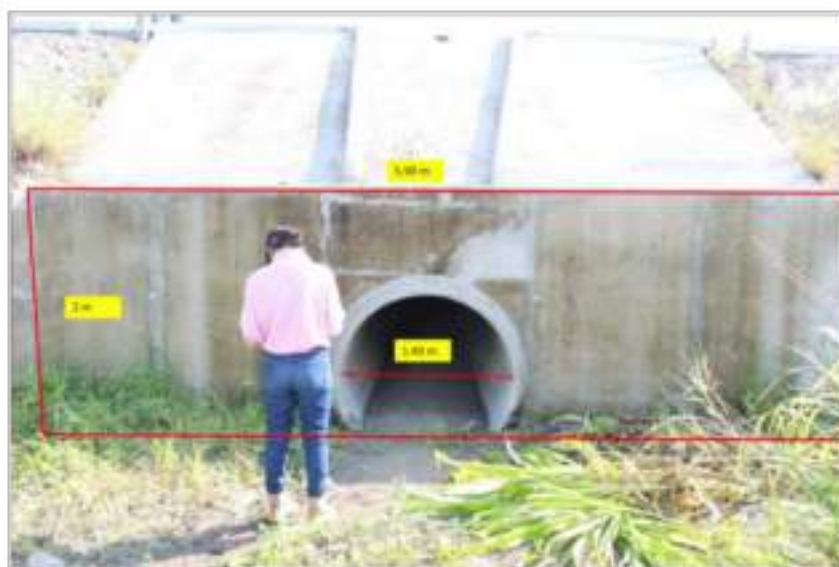
Fotografía 121. Puente alcantarilla (478508, 1847876 UTM).
