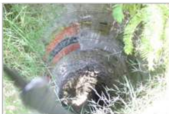
Fotografía 109. Pozo de extracción en el cauce natural.
