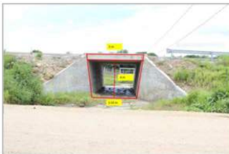
Fotografía 123. Puente con alerones (479599, 1847106 UTM).
