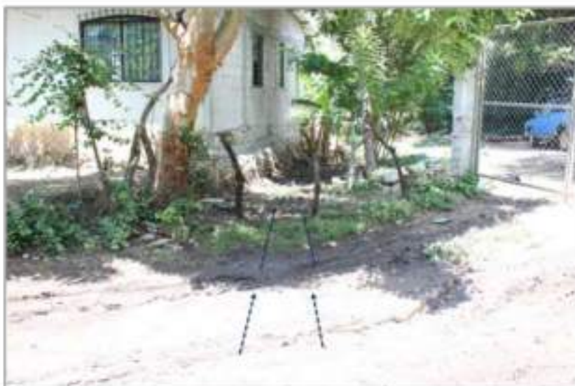
Fotografía 106. Las flechas indican el flujo de los escurrimientos, dirección norte-sur, que atraviesan la vialidad de terracería y luego rodean viviendas.
