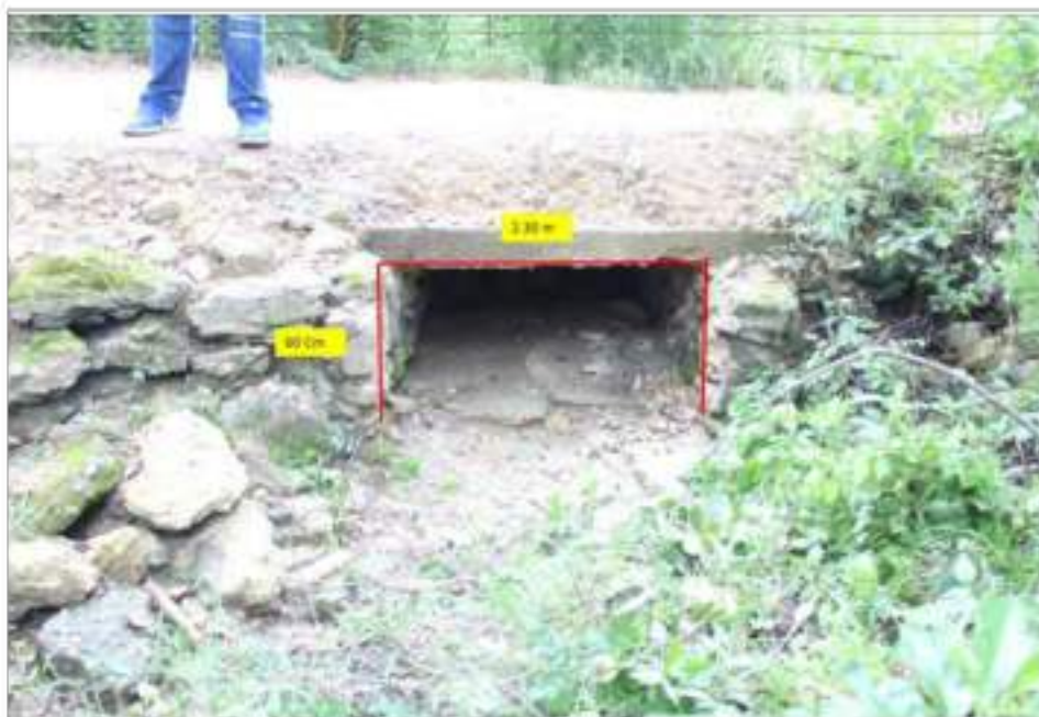
Fotografía 115. Puente rectangular para paso vehicular en camino de terracería.
