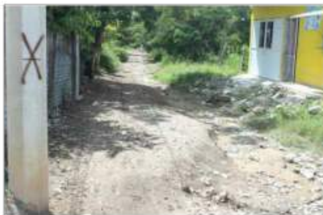
Fotografía 159. Vialidad y viviendas en calle Los Tulipanes, colonia CCI; sin evidencia de susceptibilidad por remoción en masa.
