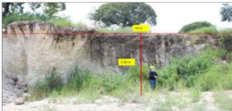
Fotografía 146. Talud de caliche macizo y cementado, camino rural a Pacú.
