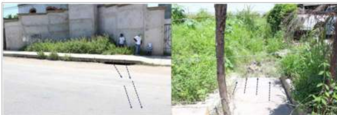
Fotografías 86 y 87 (izq. y der.). Cauce de escurrimiento natural con flujo este-oeste, que fue modificado por construcciones y obstrucción total del canal pluvial que atraviesa la vialidad, por lo que fluye sobre el asfalto hasta llegar a vertedero pluvial.
