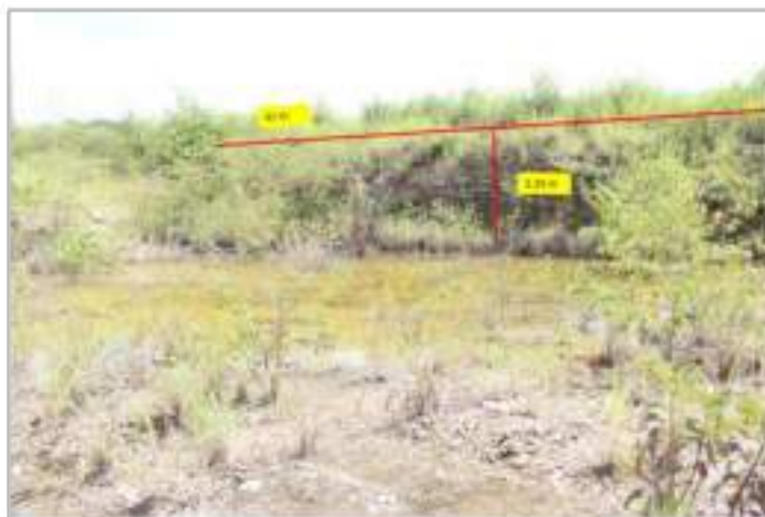
Fotografía 171. Depósito de material no compactado colindante con el Nuevo Libramiento Sur.
