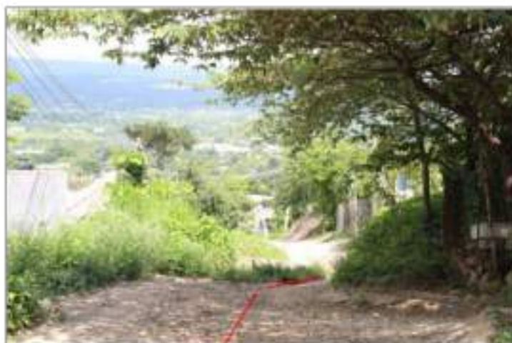
Fotografía 223. Vialidad de terracería con pendiente pronunciada, no se observa inclinación de postes ni de árboles.
