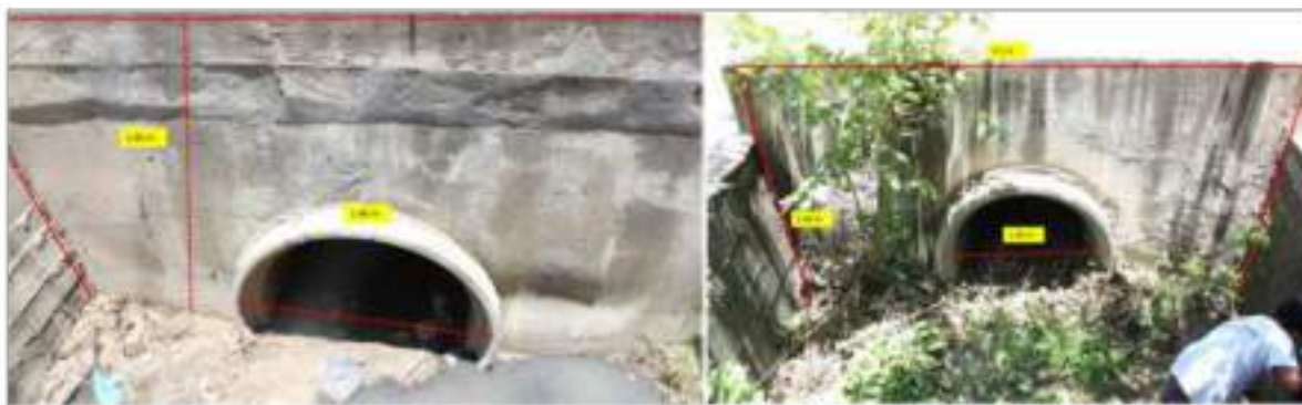
Fotografía 79 (izq.). Punto de control 10, canal pluvial sobre vialidad del camino rural a Pacú.
