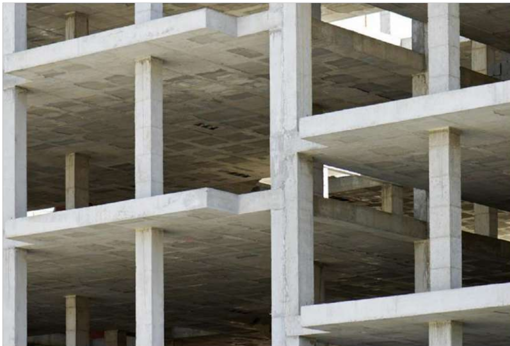
FIGURA 1. EDIFICIO CON LOSAS FLAT SLAB
