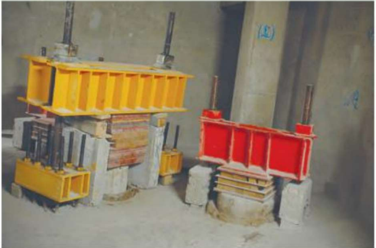
Pilotes de control colocados debajo del Sagrario Metropolitano.
