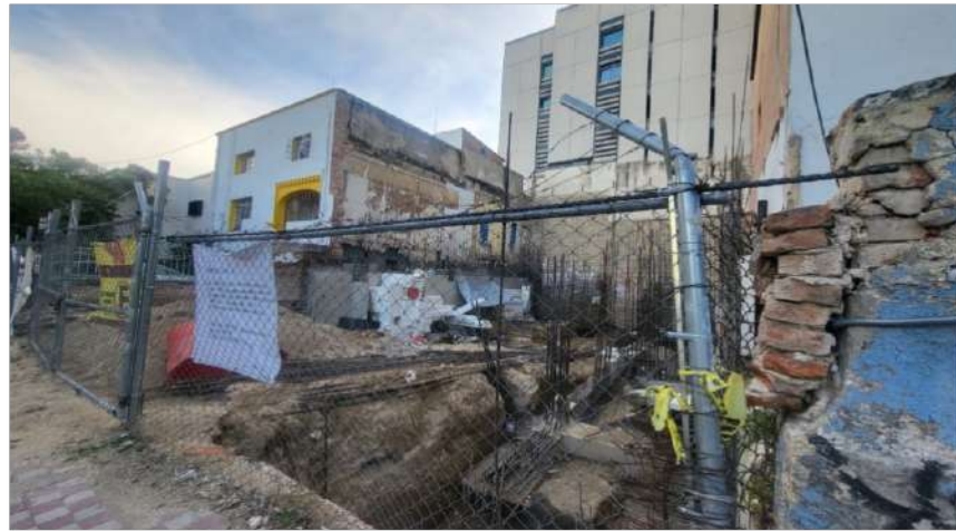
Anexo 14 - Demolición de casa habitación, para construcción de Edificio
