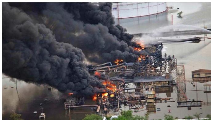
Figura 7 Incendio de Tanque
